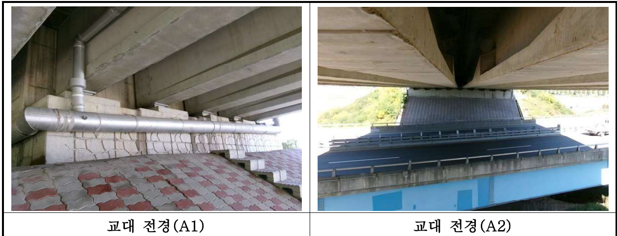
【사진 34.3.8】 교대 전경
