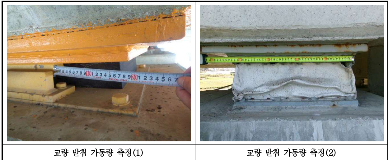
【사진 34.3.15】 교량받침 이동량 측정
