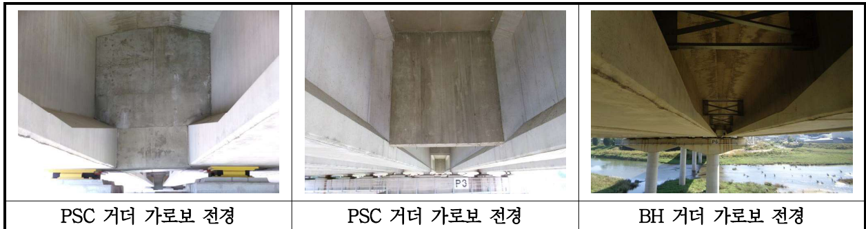
【사진 34.3.6】 가로보 전경
