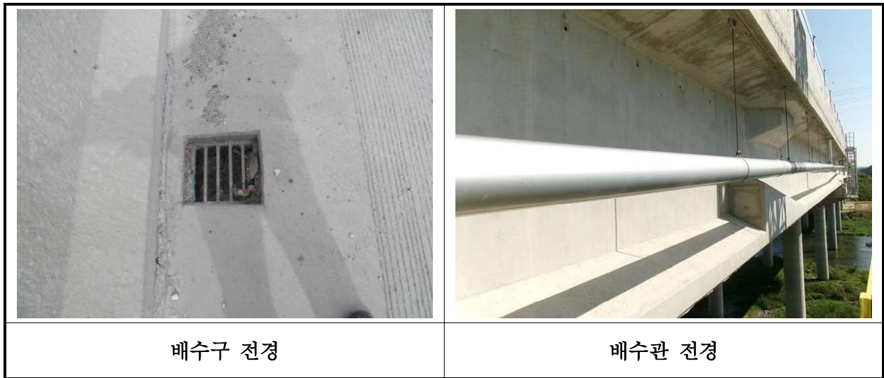
【사진 34.3.21】 배수시설 전경
