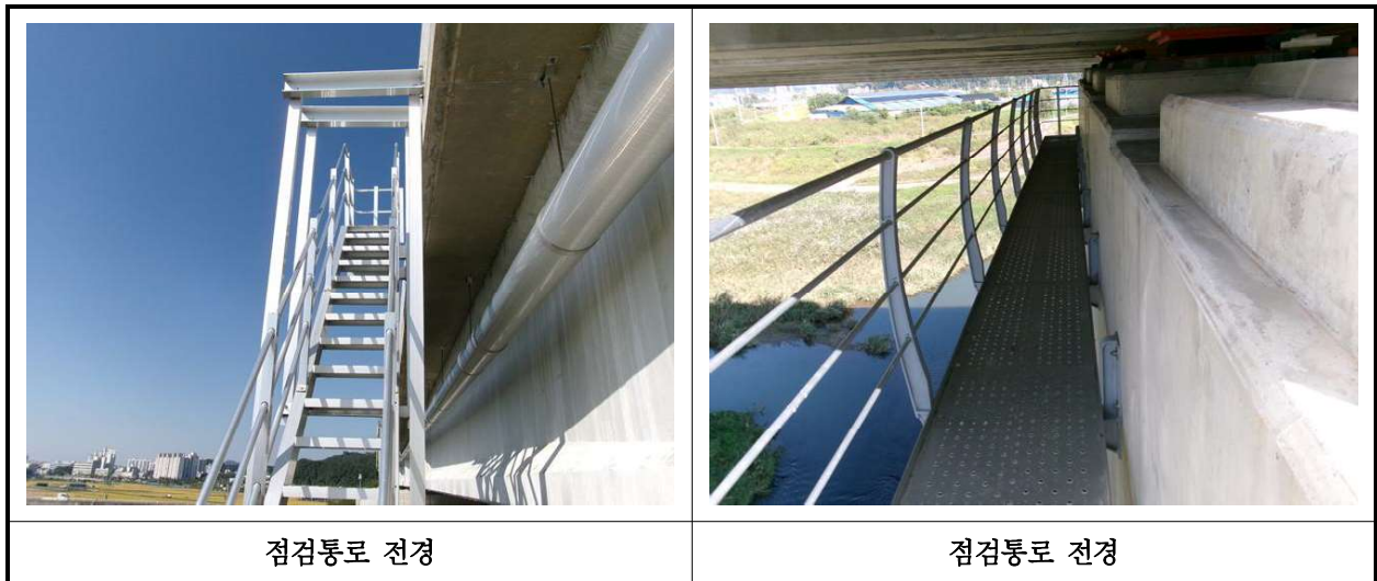
【사진 34.3.25】 교량 점검시설 전경
