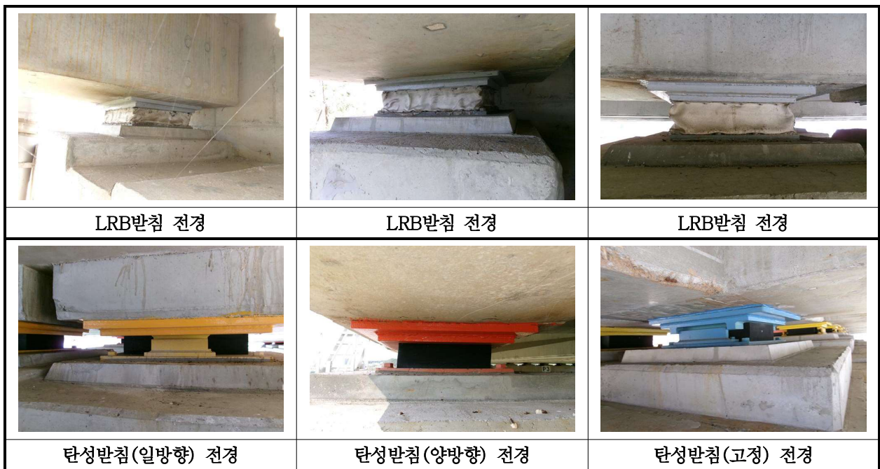
【사진 34.3.12】 교량받침 전경
