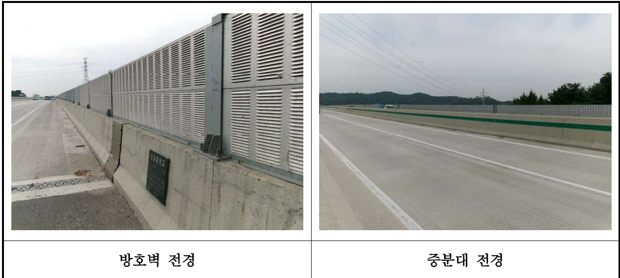
【사진 34.3.23】 방호벽 및 중앙분리대 전경
