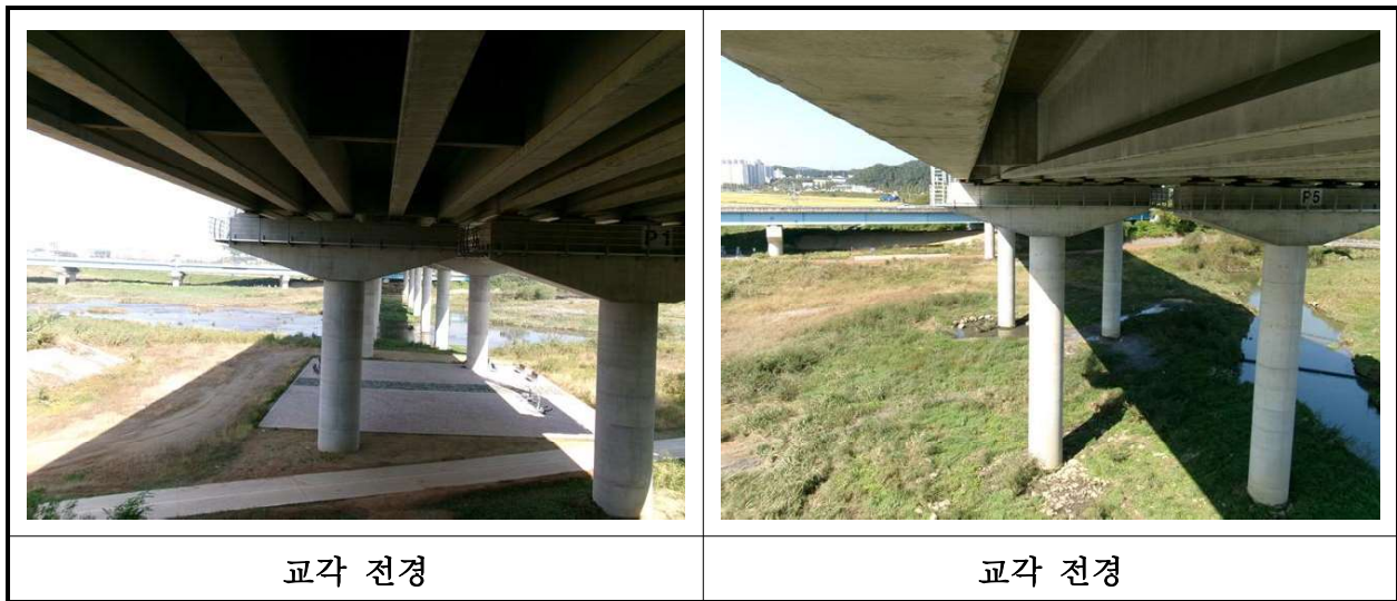
【사진 34.3.10】 교각 전경
