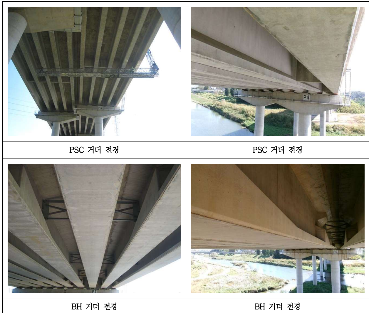
【사진 34.3.4】 거더 전경
