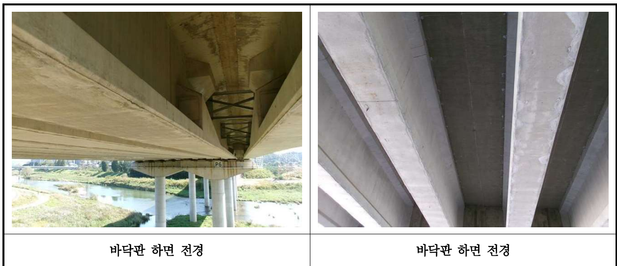
【사진 34.3.2】 바닥판하면 전경
