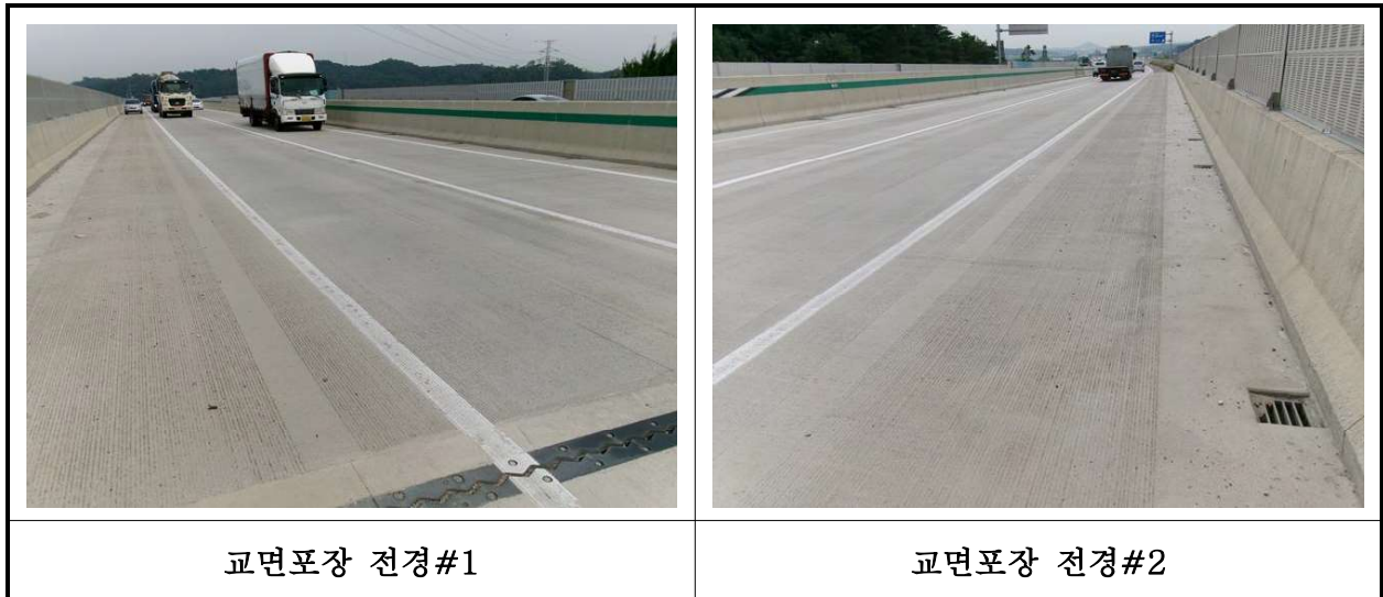
【사진 34.3.19】 교면포장 전경
