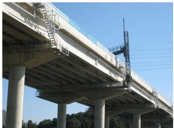
굴절차를 이용한 거더 근접조사
