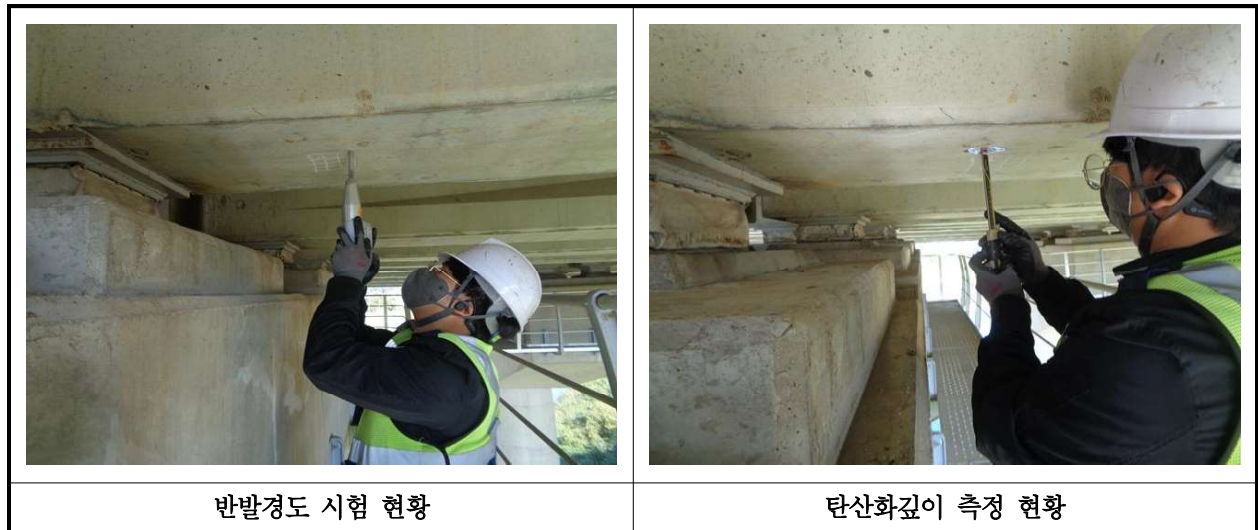
【사진 34.4.1】 콘크리트 내구성조사 현황
